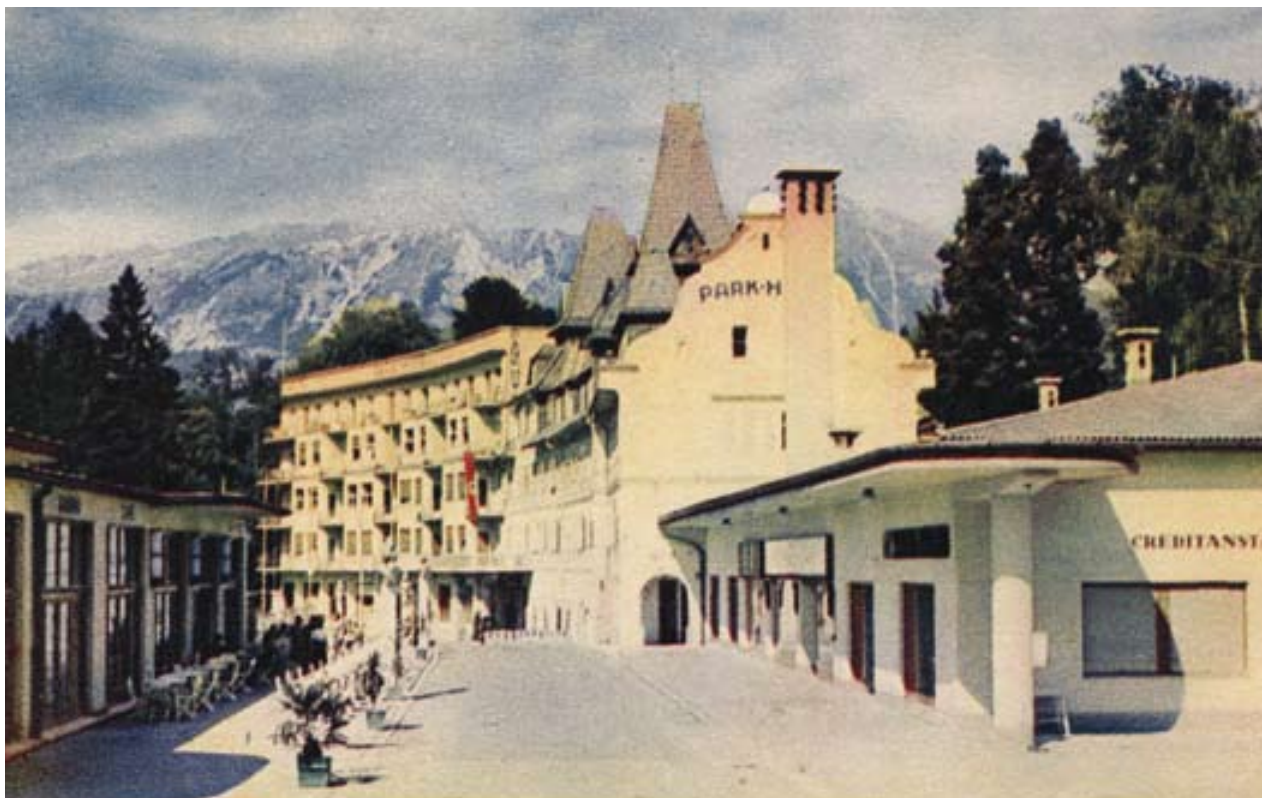
V stavbi hotela Park je bil med vojno sedež gestapa in varnostne službe. Hotel so porušili leta 1975 (zbirka Poldi Kolmana).
